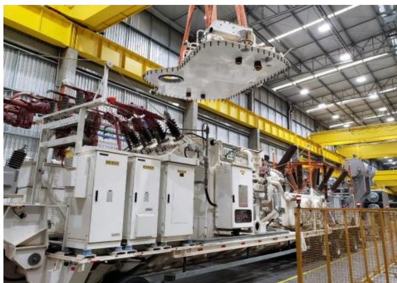
Figura A.2 - Retirada da Tampa Superior do Transformador
